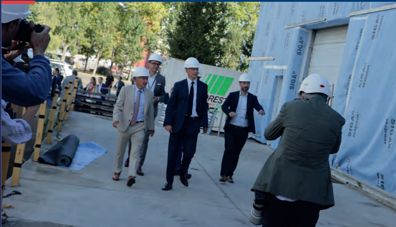
Visite du chantier de rénovation thermique. Le projet utilisera des matériaux biosourcés : isolation mixte avec fibres végétales, et bardage bois. Des nichoirs à oiseaux seront aussi installés.
