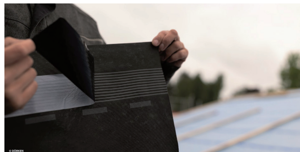
Mise en œuvre de l'écran sous-toiture de la gamme DELTA XX PLUS doté de bandes adhésives.
